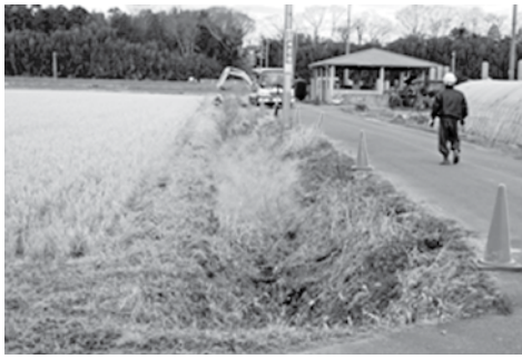
排水路 改修前
