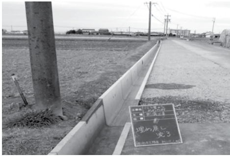
排水路 改修後
