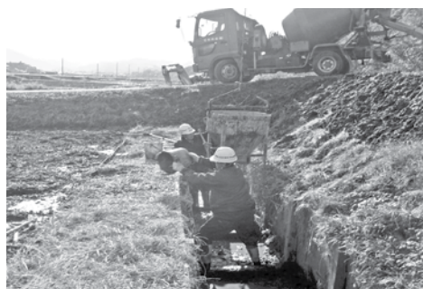
排水路の底打ち
